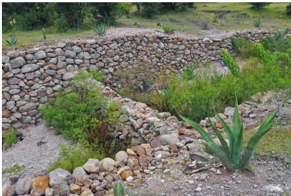
En 2019 y 2020, miembros de la comunidad del Ejido Los Toriles, con la ayuda de un especialista de la comunidad, manejo, recuperación de suelos y reforestación, construyeron barreras de piedra, conocidas como gaviones. Estas barreras detendrán la escorrentía de la cuenca después de las fuertes lluvias, lo que permitirá que la tierra y la vegetación comiencen a acumularse en el gavión, lo que resultará en la recuperación del suelo. Como muestra la foto, los agaves también se plantan en lugares estratégicos para fijar el suelo en su lugar con mayor firmeza. Imagen cortesía de Alejandro Vasconcelos.
